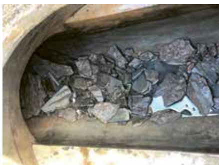
Abgelöstes Betonit-Gestein in der Meteorleitung und durchtrennte Abwasserleitung
