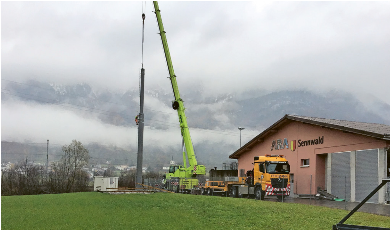
Installation Mobilfunkantenne
