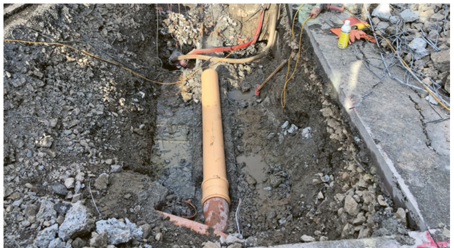
Erschwerte Bedingungen bei der Leitungsfreilegung
