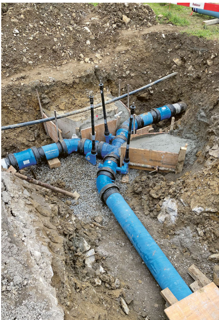
Klappeneinbau Umlegung Werdenberger Binnenkanal/Sägengasse
