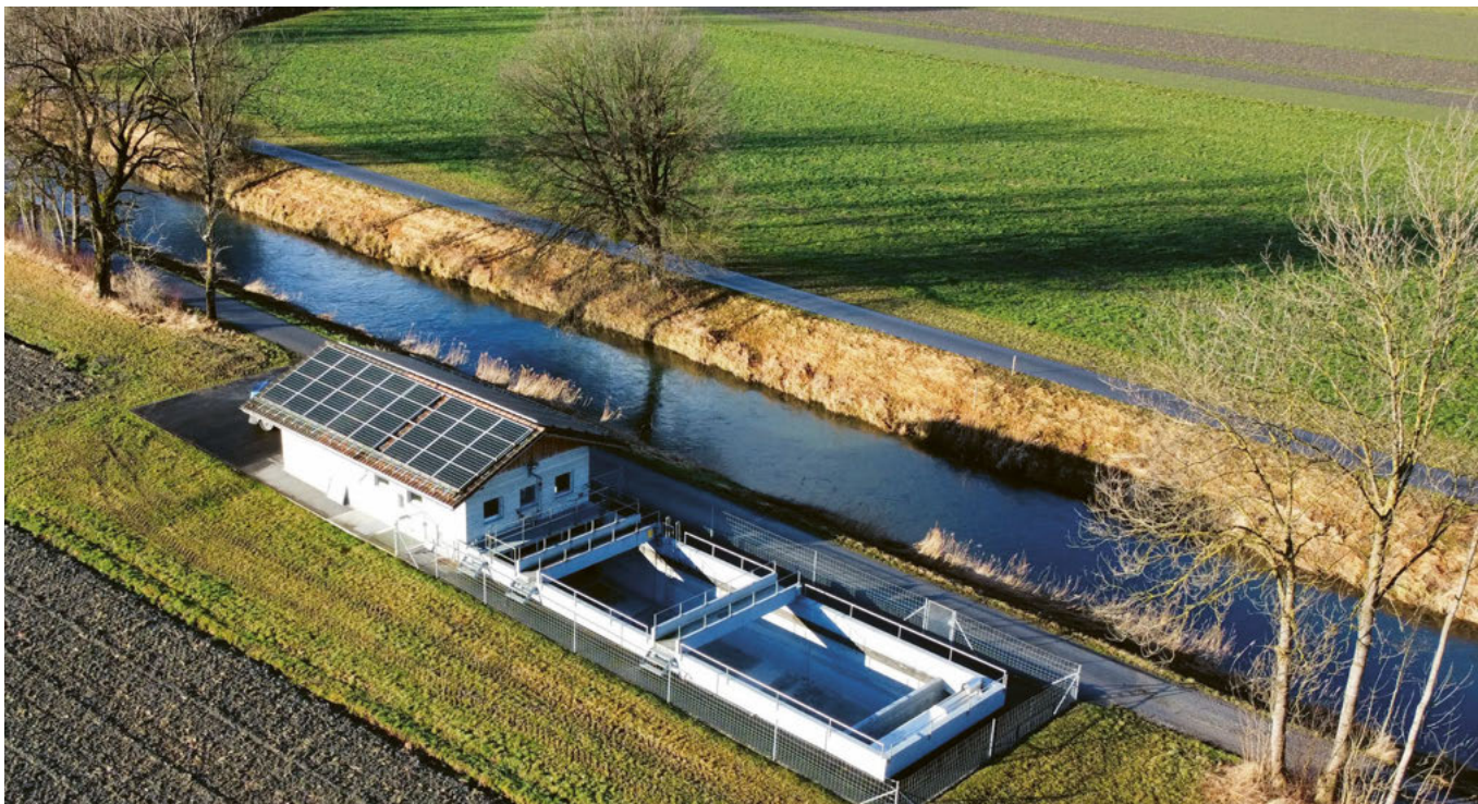
Pumpwerk mit Regenüberlaufbecken Fohlenweid
