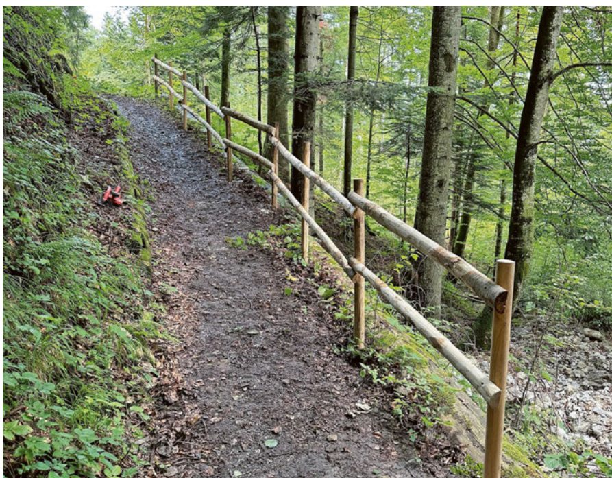
neues Geländer Rheintaler Höhenweg, Sax
